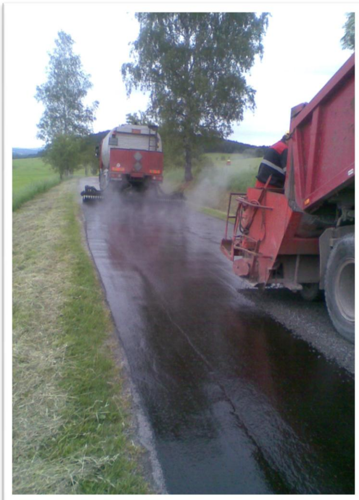
▲ Postřik emulze Vialit 065K Distributorem, podrcení kamenivem 4/8
