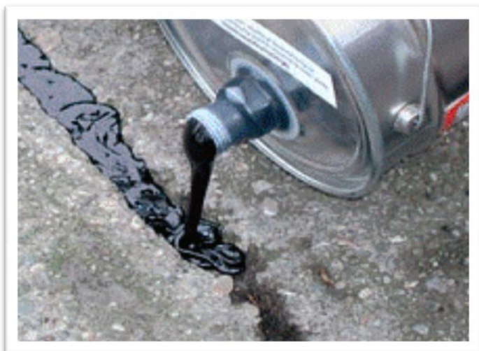
4) zalijeme spár, trhlinu, apod.
