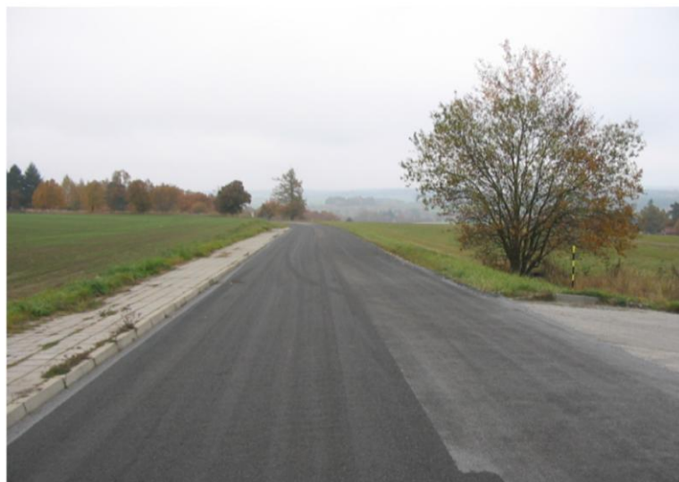
◀ Jednoduchý nátěr (oprava MK Bechyně). Povrch komunikace opravem asfaltovým betonem a proveden jednoduchý nátěr emulze Vialit 065K , zadrčení kamenivem 4/8.
