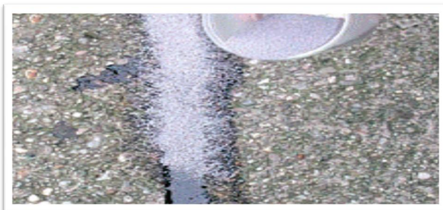
5) zarovnáme a posypeme Vialit – spárovacím práškem
